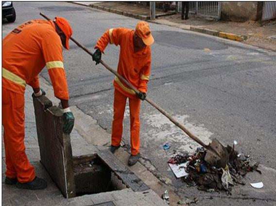
Figura 10– Limpeza manual de sarjetas. Fonte: <http://plox.com.br> (2015).
