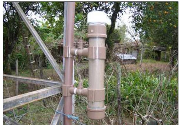
**Figura 8 – Clorador artesanal para poço.**
